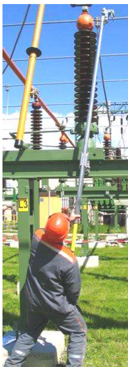
Obr. 13: zdvihání propojovací zemnicí a zkratovací tyče přesně vymezeným směrem
