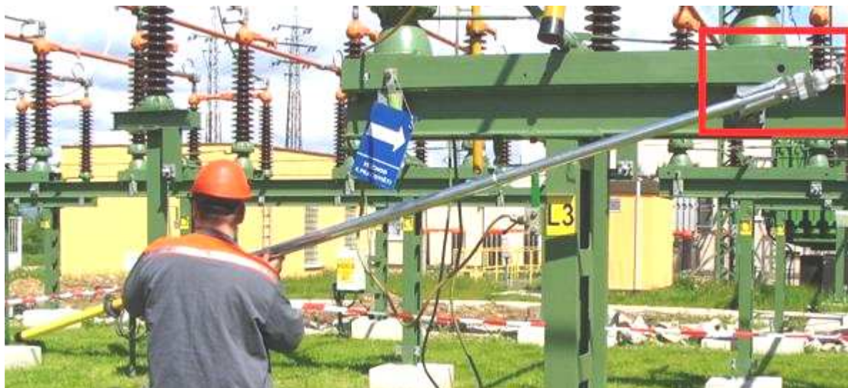
Obr. 12: instalace propojovací zemnicí a zkratovací tyče do vodící objímky
